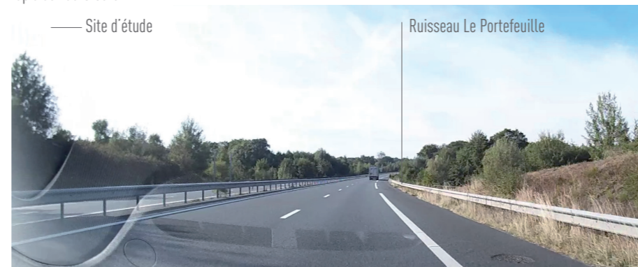
8. Le terrassement de l'autoroute annule le micro-relief comme ici, où l'autoroute franchit le ruisseau Le Portefeuille. L'ensemble est accompagné d'une végétation épaisse sans visibilité du site d'étude.
