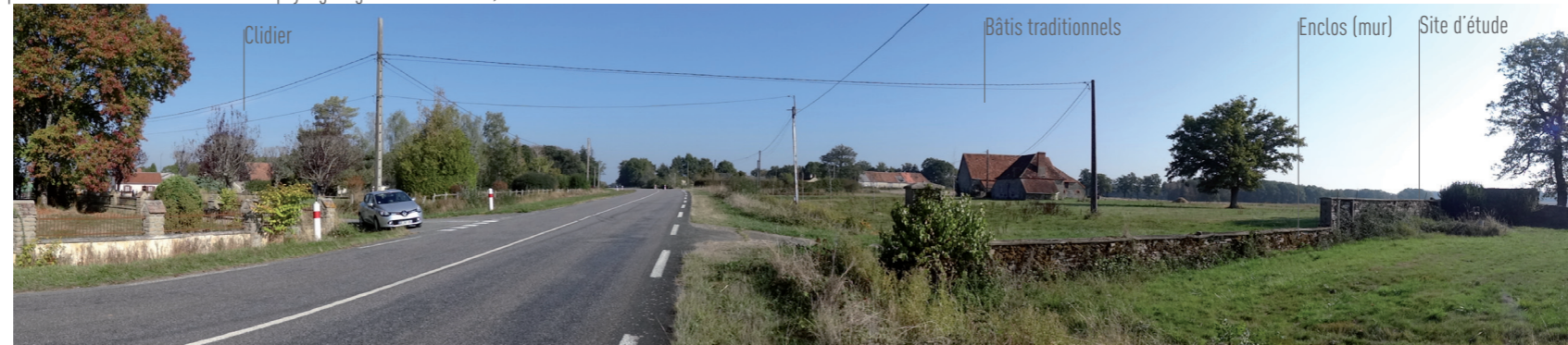
5. Deux corps de fermes, un enclos et quelques arbres isolés témoignent d'une exploitation agricole abandonnée. Cependant, ils qualifient l'interface entre Clidier et le secteur naturel et offrent un motif paysager. Les maisons de Clidier se trouvent plutôt en retrait de cet axe routier important et s'articulent autour d'un espace vert à gauche dans l'image.
