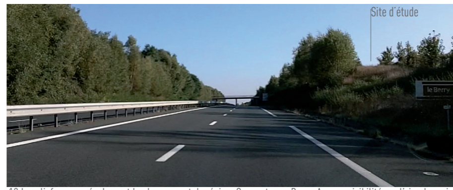
10. Le relief marque également le changement de région. On y entre au Berry. Aucune visibilité sur l'aire de projet.
